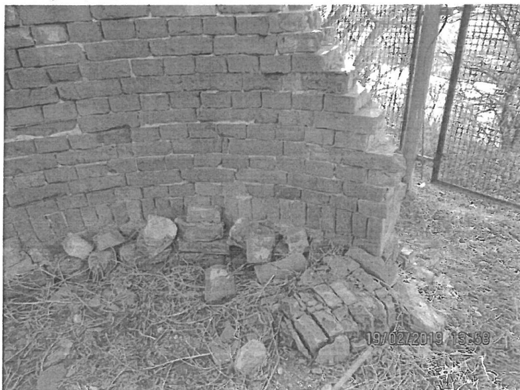
6. Gruz ceglany do segregacji.
